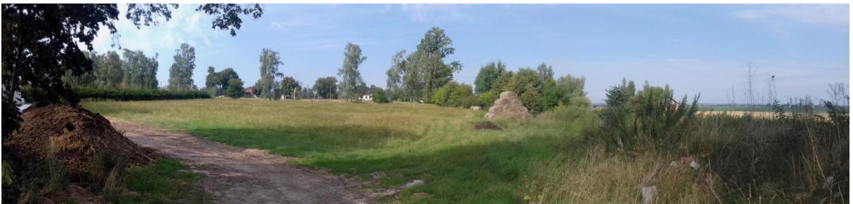
Fot. 3. Widok w kierunku zachodnim na północną część obszaru projektu „Planu...”, na pierwszym planie składowiska ziemi i gruzu.
